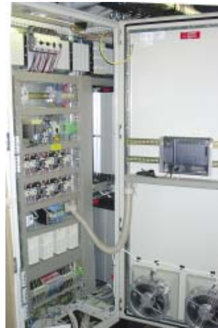
Honeywell Excel Web im Einsatz bei der Heinrich-Heine Universität in Düsseldorf.
